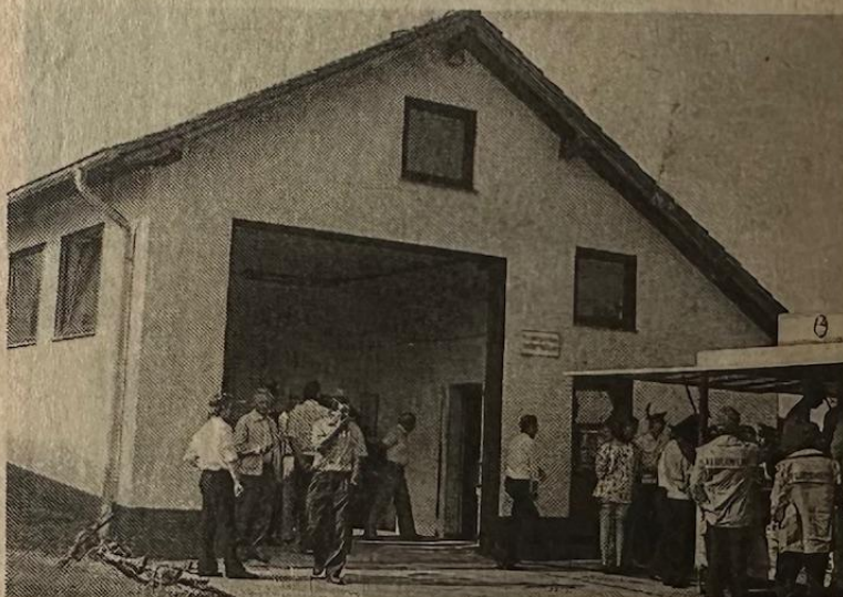
Das Gerätehaus der Löschgruppe Weyer konnte nach langer Bauzeit am Wochenende eingeweiht werden. (Bild: Karin Vogelsberg)
